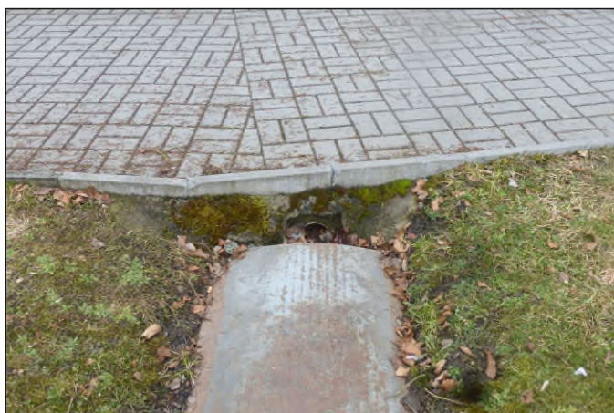
Propustek 15d - staničení 0,073 - pohled zleva
