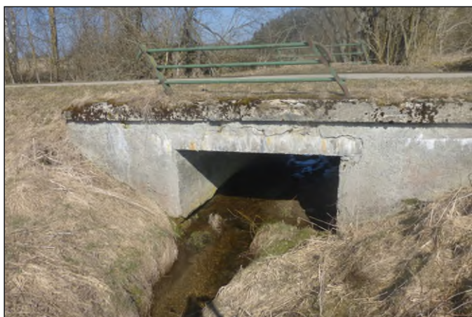
Most 37c-M1 - staničení 0,750 - pohled zprava
