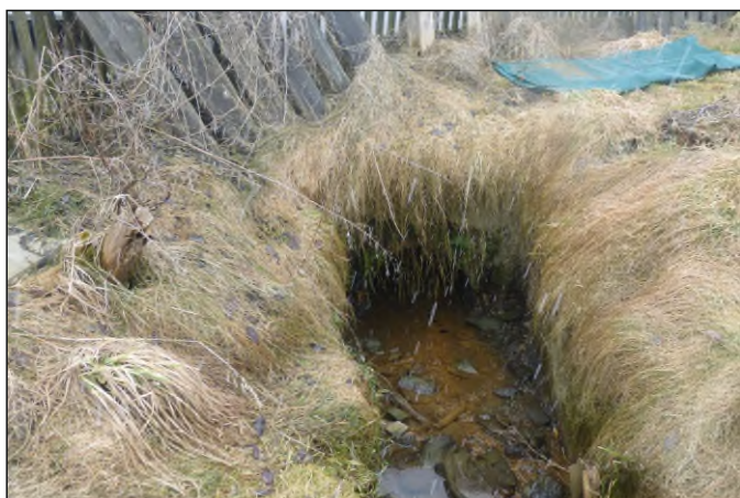
Propustek 16c - staničení 0,203 - pohled zprava
