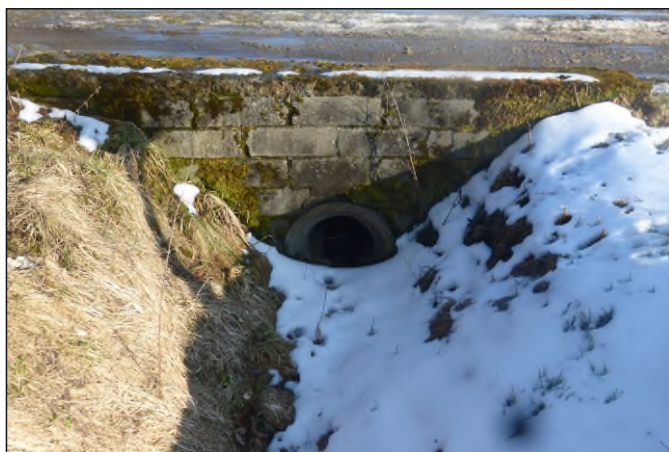
Propustek 39c - staničení 1,097 - pohled zleva
