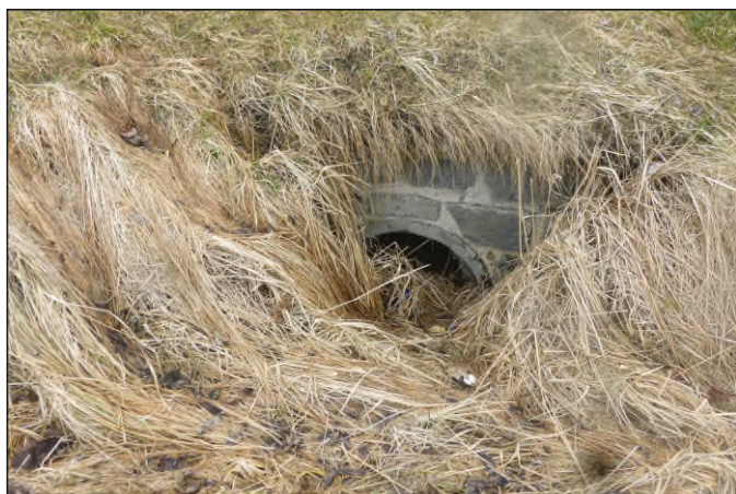
Propustek 19c - staničení 0,035 - pohled zleva
