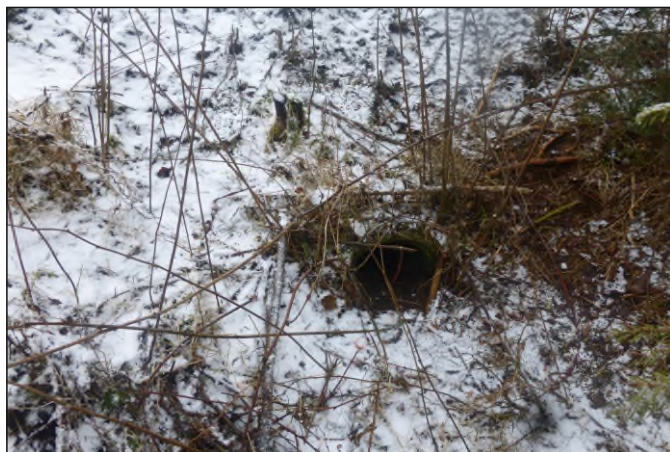
Propustek 2d - staničení 0,089 - pohled zleva
