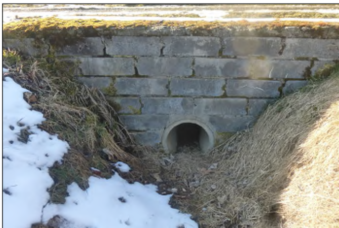
Propustek 37c - staničení 1,097 - pohled zprava
