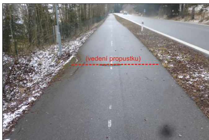
Propustek 5d - staničení 1,100 - celkový pohled
