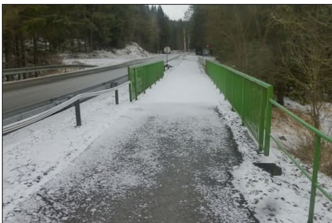
Lávka 1d-L2 - staničení 0,699 - celkový pohled
