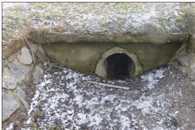
Propustek 1c - staničení 0,004 - pohled zleva
