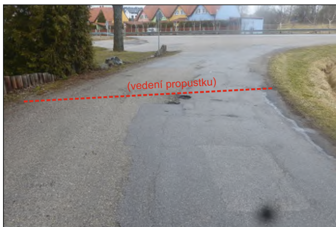
Propustek 19c - staničení 0,035 - celkový pohled
