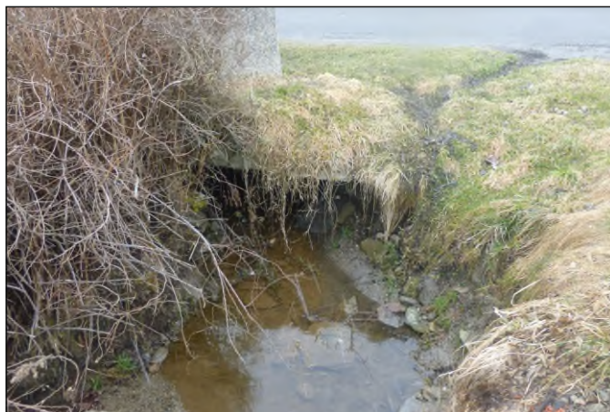
Propustek 16c - staničení 0,203 - pohled zleva
