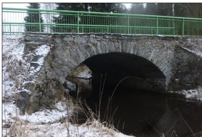
Lávka 1d-L1 - staničení 0,307 - pohled zprava
