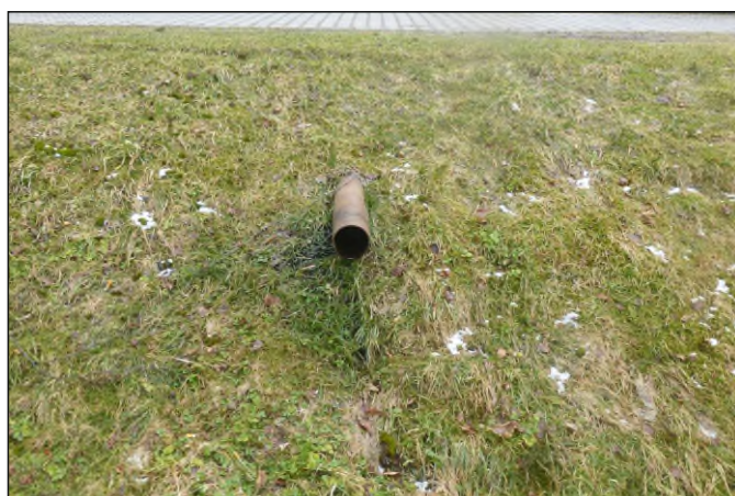
Propustek 14d - staničení 0,160 - pohled zleva
