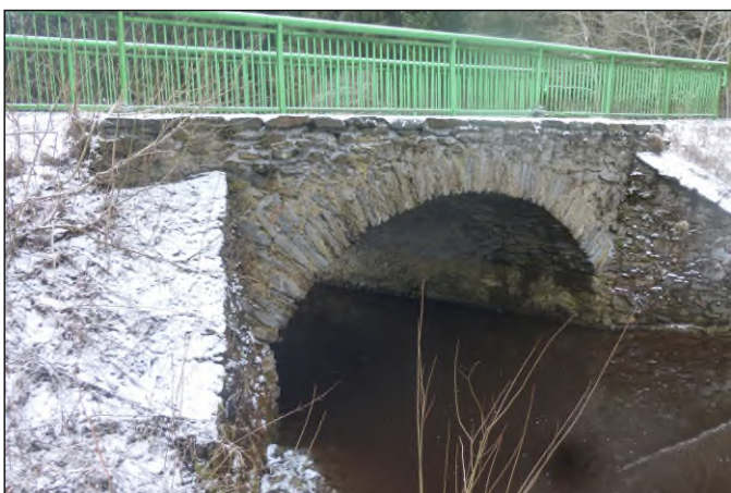
Lávka 1d-L1 - staničení 0,307 - pohled zleva
