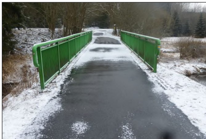
Lávka 1d-L1 - staničení 0,307 - celkový pohled
