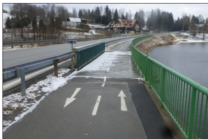
Lávka 5d-L1 - staničení 0,299 - celkový pohled
