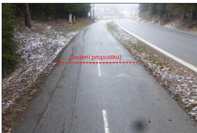
Propustek 5d - staničení 0,612 - celkový pohled
