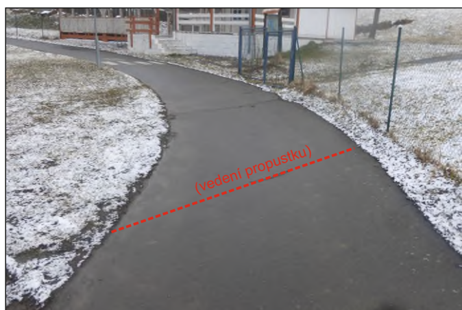
Propustek 2d - staničení 0,609 - celkový pohled
