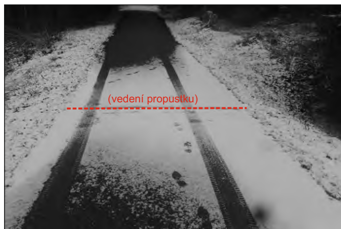
Propustek 2d - staničení 0,089 - celkový pohled
