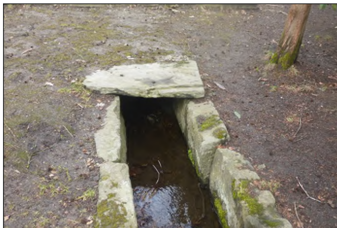
Propustek 15d - staničení 0,008 - pohled zprava
