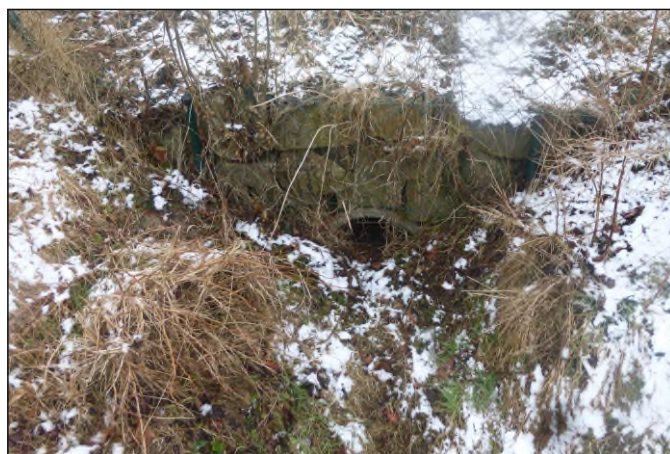
Propustek 5d - staničení 0,790 - pohled zprava
