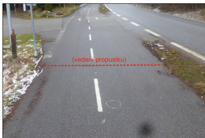
Propustek 5d - staničení 0,790 - celkový pohled
