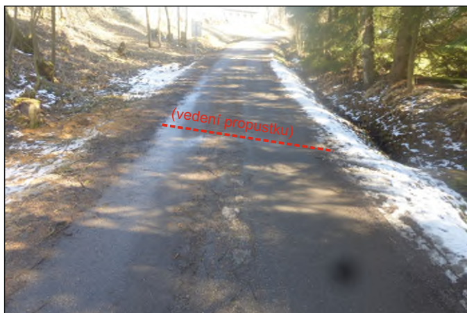
Propustek 36c - staničení 0,159 - celkový pohled
