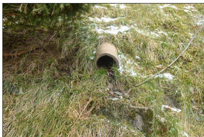
Propustek 14d - staničení 0,096 - pohled zleva
