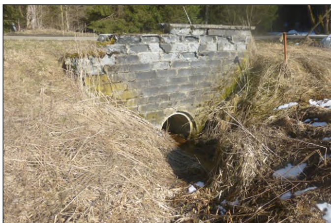
Propustek 32c - staničení 0,275 - pohled zprava
