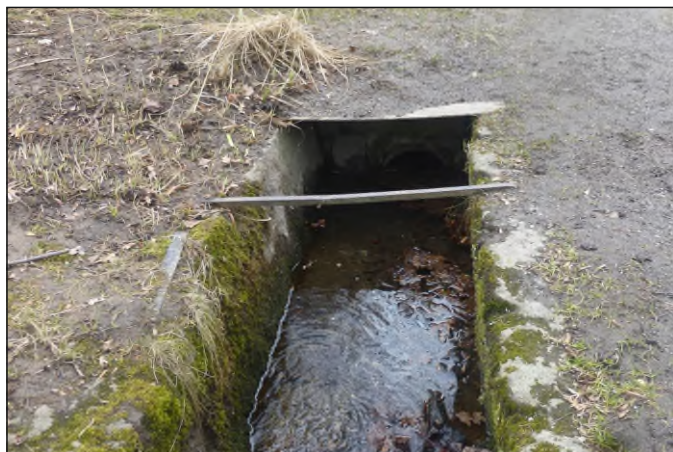
Propustek 15d - staničení 0,008 - pohled zleva
