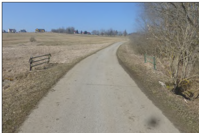
Most 37c-M1 - staničení 0,750 - celkový pohled
