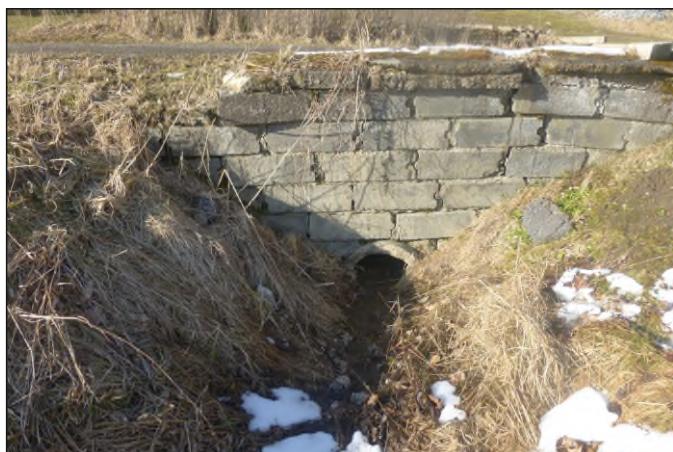
Propustek 39c - staničení 0,808 - pohled zprava
