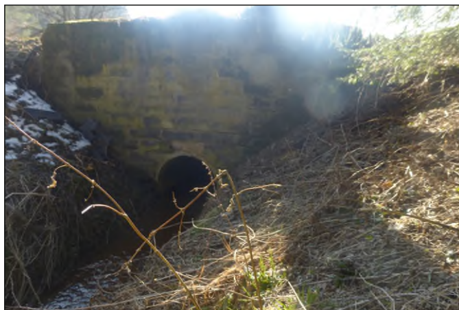
Propustek 32c - staničení 0,275 - pohled zleva
