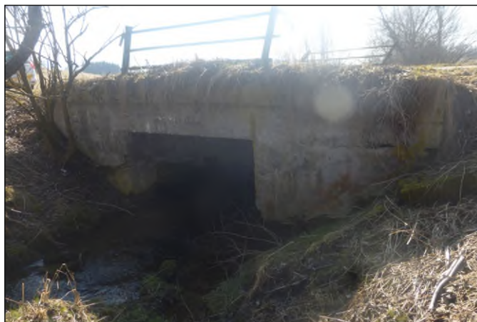
Most 37c-M1 - staničení 0,750 - pohled zleva
