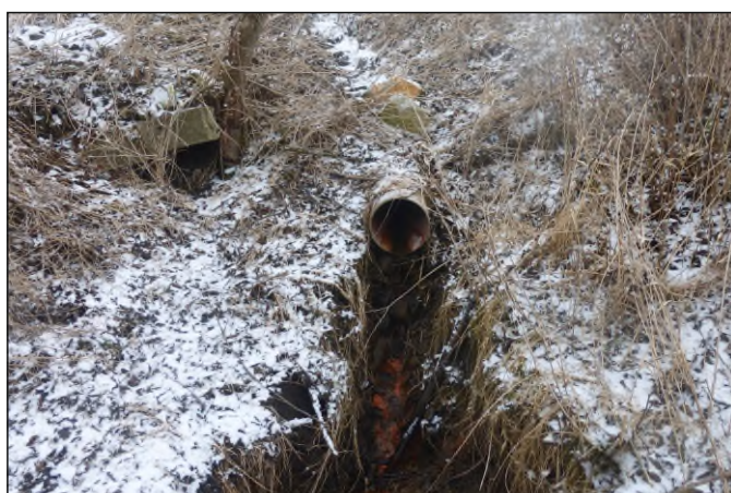
Propustek 2d - staničení 0,6019 - pohled zprava
