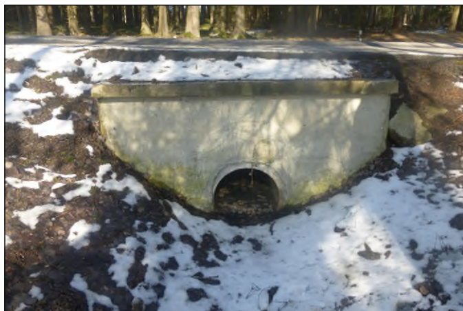
Propustek 32c - staničení 0,001 - pohled zprava
