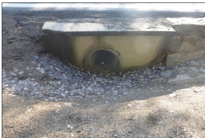
Propustek 32c - staničení 0,001 - pohled zleva
