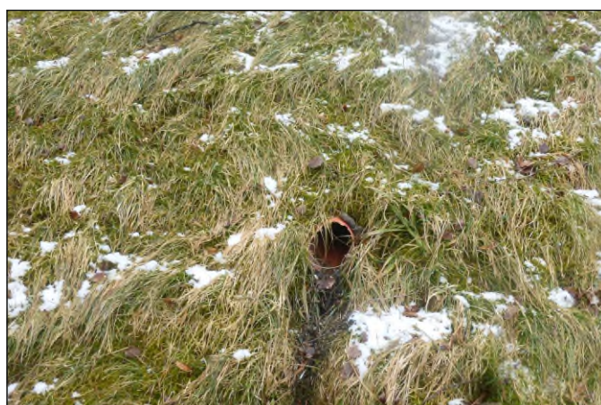
Propustek 14d - staničení 0,085 - pohled zleva
