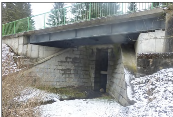
Lávka 1d-L2 - staničení 0,699 - pohled zprava
