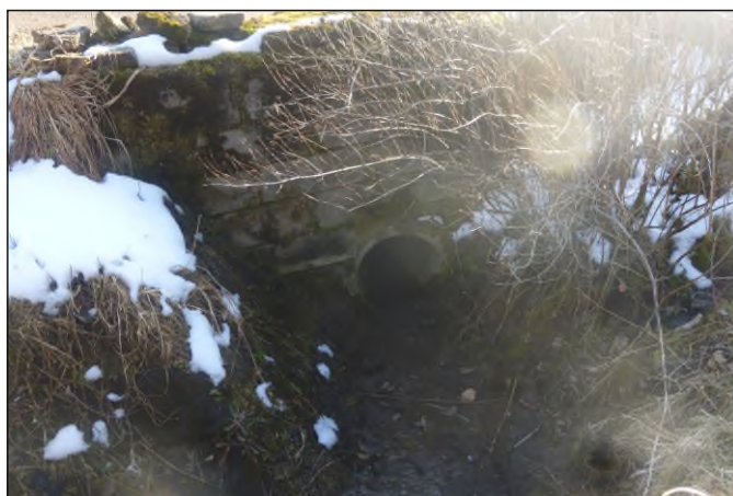
Propustek 39c - staničení 0,808 - pohled zleva
