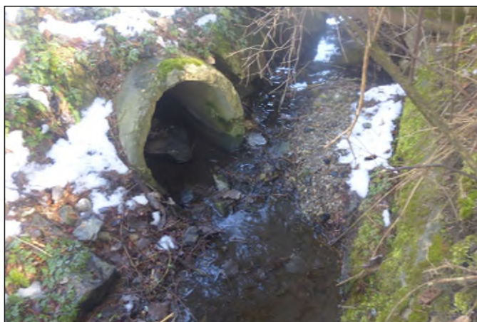
Propustek 36c - staničení 0,159 - pohled zleva
